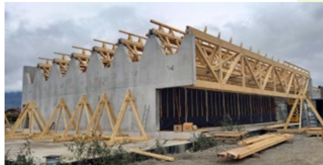
● Avancée des travaux de l'espace intercommunal sportif et culturel - Déc.2024
