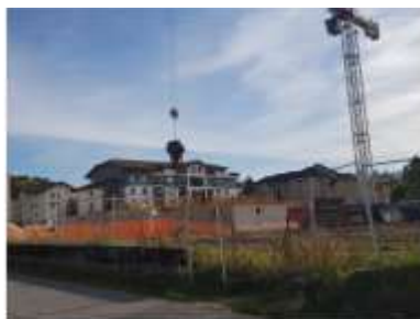
Opération HSS, Rue des Ecoles – Reignier-Esery
